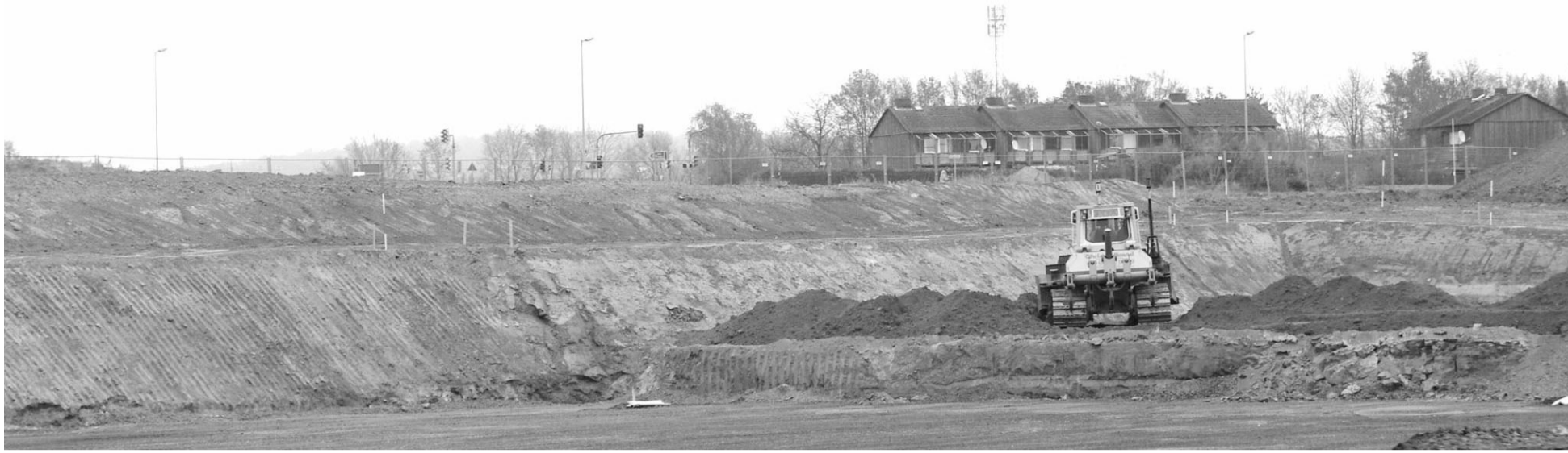
Die Bagger waren schon fleißig: Auf 16 000 Quadratmetern entsteht im Gewerbepark das neue Logistikzentrum der Gebrüder Heinemann.
